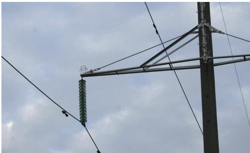
2.5. ВЛ 220 кВ условно является действующей электроустановкой в момент прибытия бригады уже выведена в ремонт оперативным персоналом полигона отключением коммутационных аппаратов на подстанциях и включением заземляющих ножей на линейных разъединителях в сторону ВЛ, ВЛ не находится под наведенным напряжением. Бригадой заземляется только ремонтируемая фаза (остальные условно).
